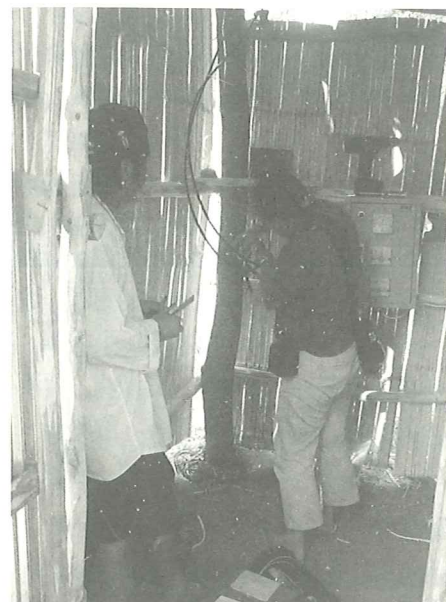
TOPS 技術人員正在裝設水力發電裝置
