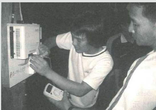
TOPS 技術人員正在裝設水力發電裝置
