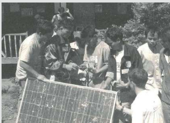
學員們實際操作架設太陽能板
